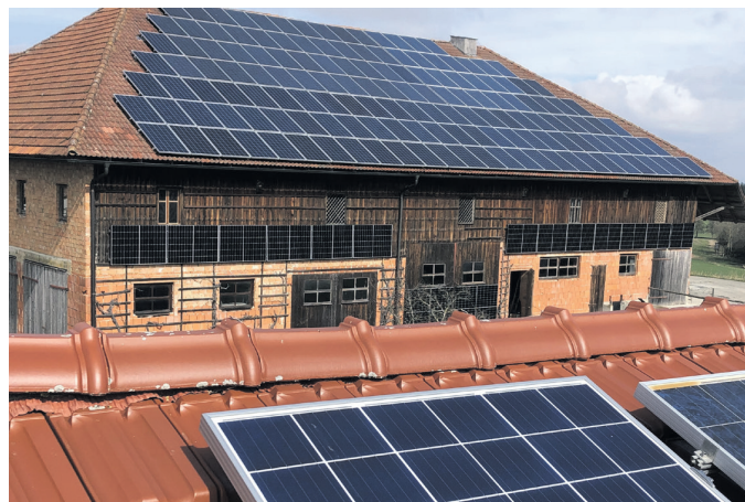
PV-Anlage am Hof.
